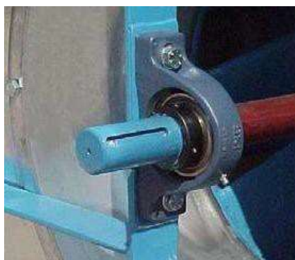
Attēls 1: Ventilatora gultnis ar eļļošanas nipelī (piemēram, Comefri NTHZ)
