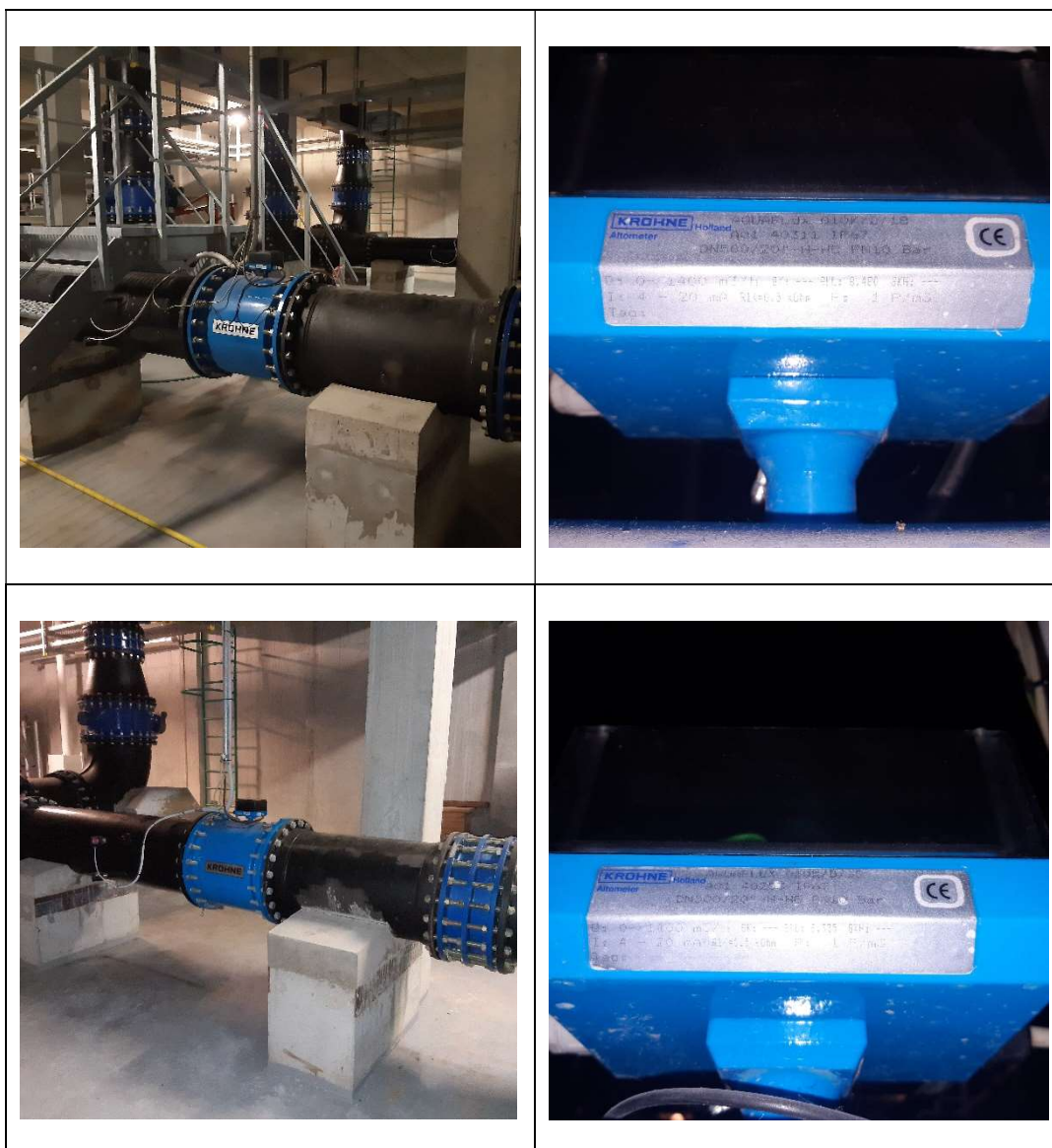
1.attēls ūdens sūkņu stacijā “Baltezers” esošo plūsmas mērītāju foto fiksācija:
