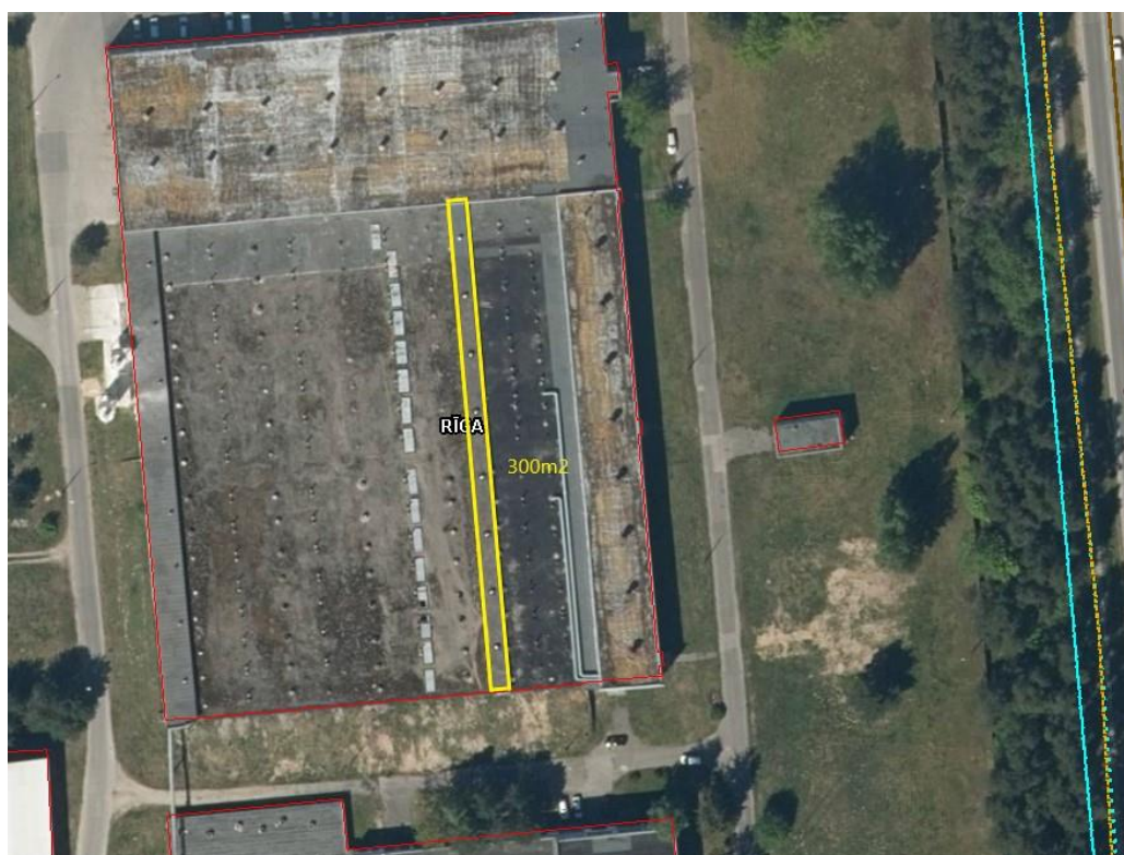
Darbu Objekts: Bauskas iela 209, Rīga ( Ēka Nr.3 )
