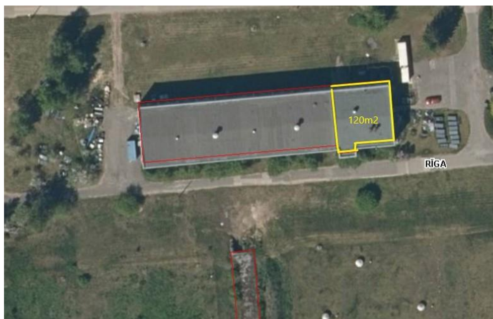
Darbu Objekts: Bauskas iela 209, Rīga ( Ēka Nr.2 )
