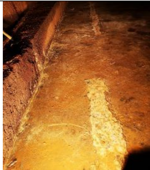
Attēls Nr.4 Kavernas dzelzsbetona pamatu virskārtā
