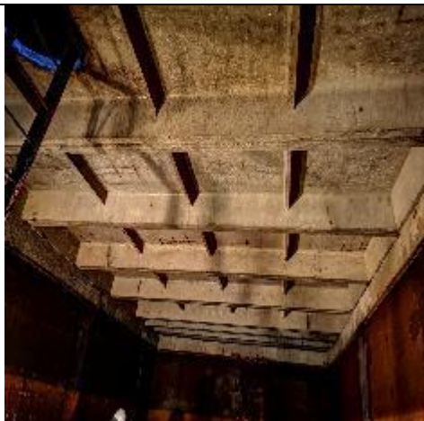
Attēls Nr.11 Skats uz rezervuāra pārsegumu
