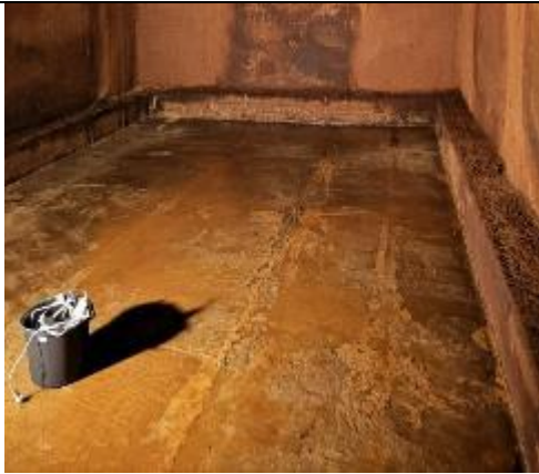
Attēls Nr.1 Skats rezervuāra pamatiem un grīdu
