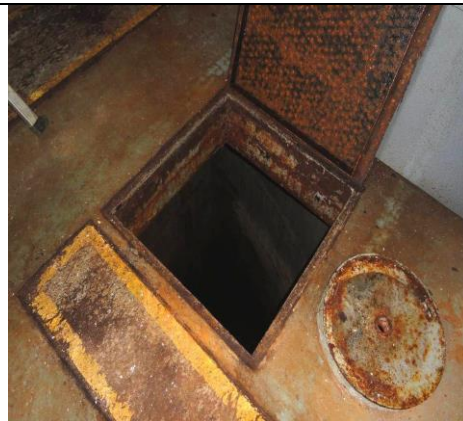
Attēls Nr.6 Tehniskā ūdens krasta akas rietumu puses kameru apkalpes lūka
