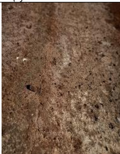
Attēls Nr.9 Rukuma plaša torkrētbetona kārtā
