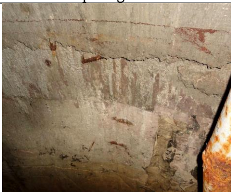
Attēls Nr.3 Tehniskā ūdens krasta akas dienvidu puses kameras ārsiena
