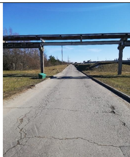
61. Galvenais ceļš gar nostādinātājiem un aerācijas baseiniem
