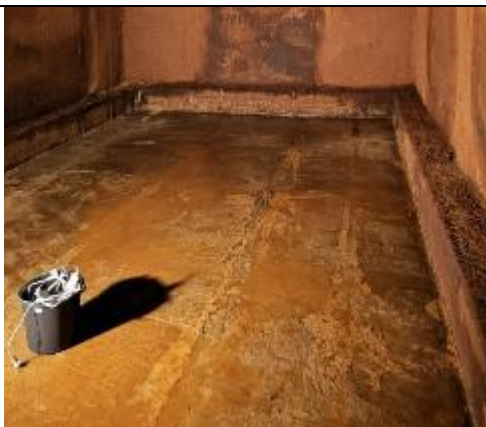
Attēls Nr.1 Skats rezervuāra pamatiem un grīdu
