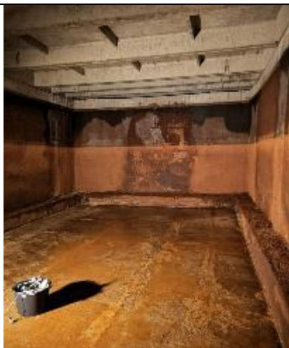
Attēls Nr.5 Skats uz rezervuāra sienām no rezervuāra iekšpuses
