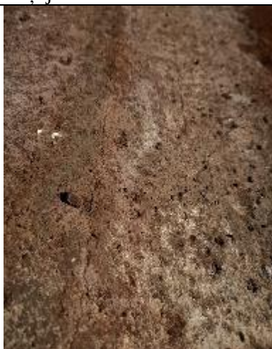
Attēls Nr.9 Rukuma plaša torkrētbetona kārtā
