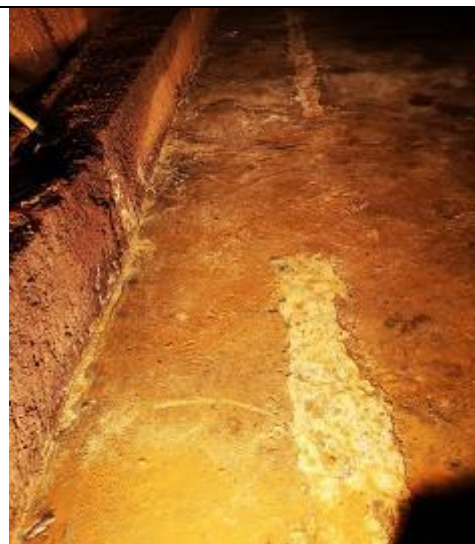
Attēls Nr.4 Kavernas dzelzsbetona pamatu virskārtā
