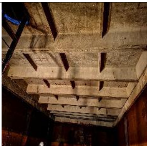
Attēls Nr.11 Skats uz rezervuāra pārsegumu
