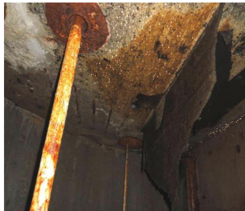
Attēls Nr.2 Tehniskā ūdens krasta akas apkalpes šahta pārsegums
